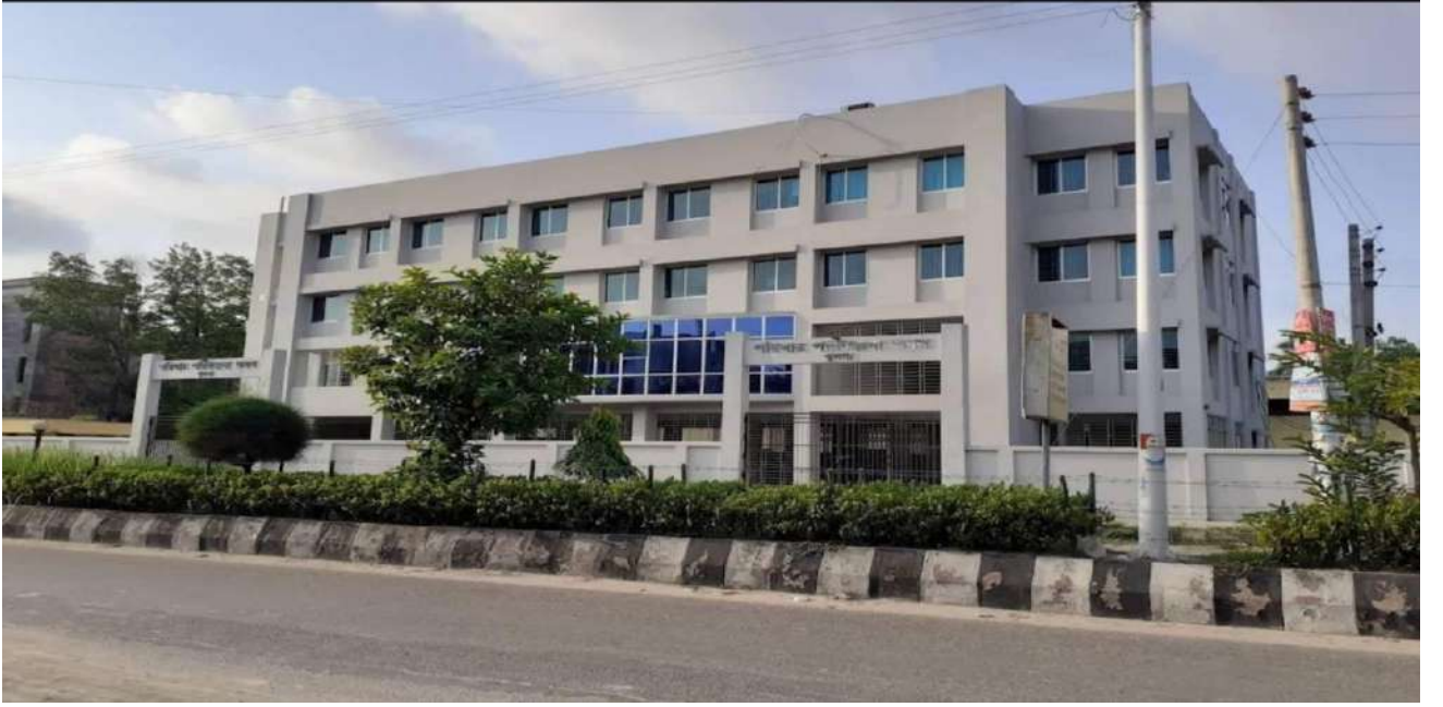
বিভাগীয় পরিচালক পরিবার পরিকল্পনা অফিস ভবন, খুলনা।
